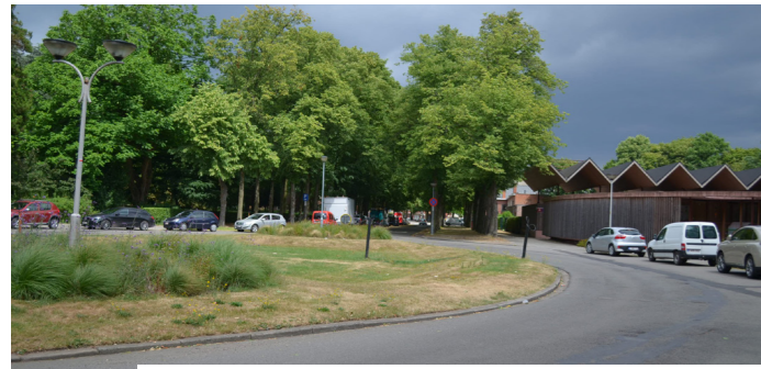
▲ Eind deze zomer gaat de Speelpleinstraat op de schop. Daarbij wordt o.a. het fietspad doorgetrokken vanuit de Terlindenhofstraat en dit in beide richtingen
