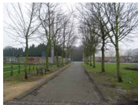
Hof Van Rosendaal: betondallen
