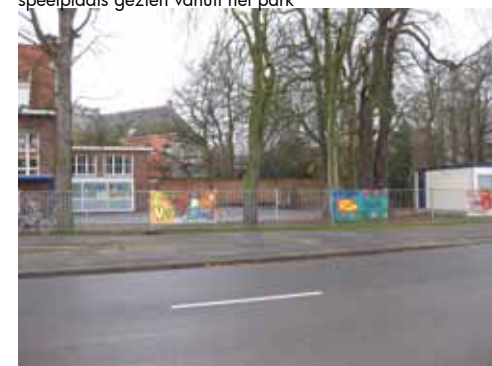
de muur tussen de binnenkoer van het Runcvoorthof en de speelplaats gezien vanaf de Terlindenhofstraat
