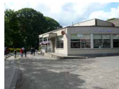
het terras van het zwembad aan de kant van de parking
