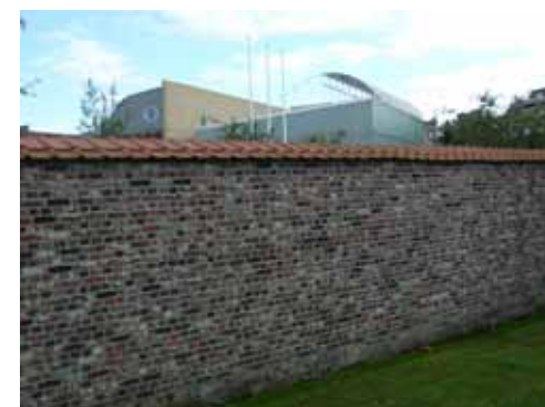
de kloostermuur die is heropgebouwd
