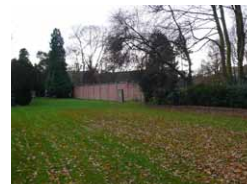
de muur gaat over in een draadafsluiting
