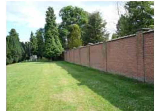
begraafplaats, bakstenen muur
