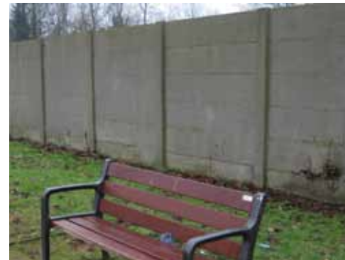
toegang Hof Van Rosendaal, betonplaten
