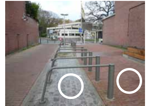
Parkweg: baksteen, kasseien, rode betondallen
