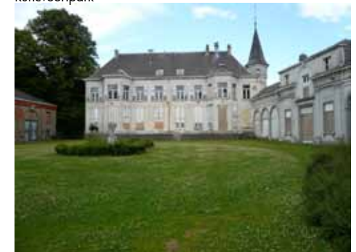
de gevel van het Runcvoorthof naar het park toe
